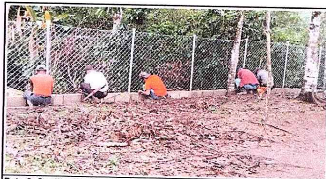
Foto 6: Sustrucción de malla perimetral en proceso
