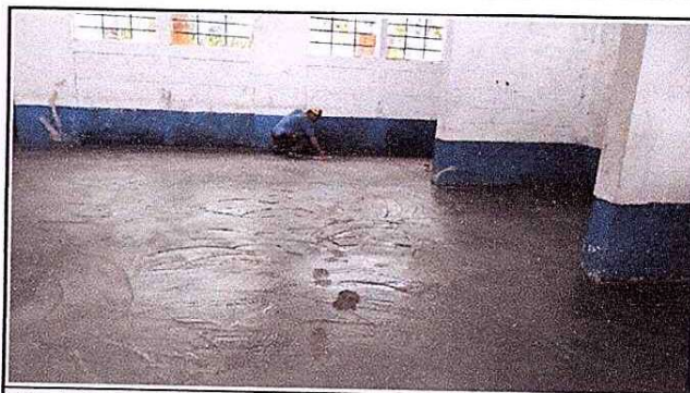
Foto 4: Sustrucción de piso de aula en proceso
