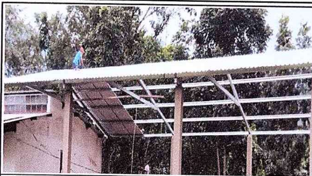
Foto 1: Sustrucción de láminas en proceso
